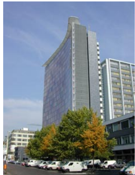
GSW's nye økoskyskraper i Berlin er eksempel på en hybrid ventilert bygning
